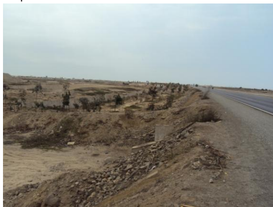
Foto N°. 12 .- Vista Panorámica de la carretera Vía de Evitamiento de la Panamericana Norte donde se aprecia el talud formado que trabaja como muro de contención para evitar la llegada del agua al Aeropuerto, en una futura avenida del Fenómeno del Niño.
