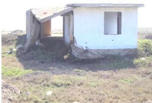
Foto Nº. 05 .- Vista Panorámica de Huanchaquito Bajo donde se aprecia una casa derrumbada por socavación como salida del agua del mar.
